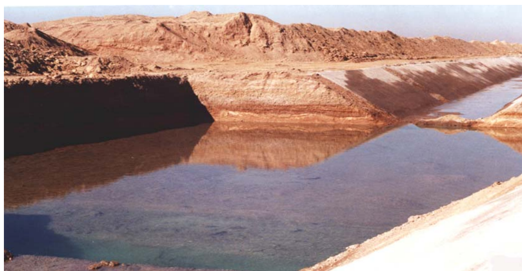
تصویر (۱۴) - وجود یون‌های سولفات فراوان در آب زیرزمینی و نیز نفوذ پذیری زیاد خاک محل باعث ایجاد پدیده خوردگی بتن در زیر بوتیل گردیده است
