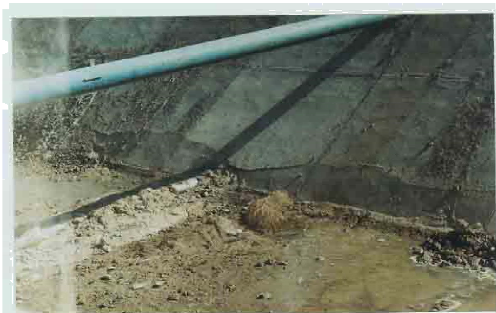
تصویر شماره (۴) - تخریب کانال در اثر فشار هیدروستاتیک
