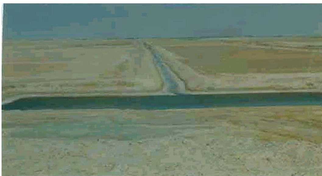
تصویر شماره (۲۴) - حوضچه‌های تبخیری جهت پیشگیری از ورود آب املاح دار به زاینده رود
