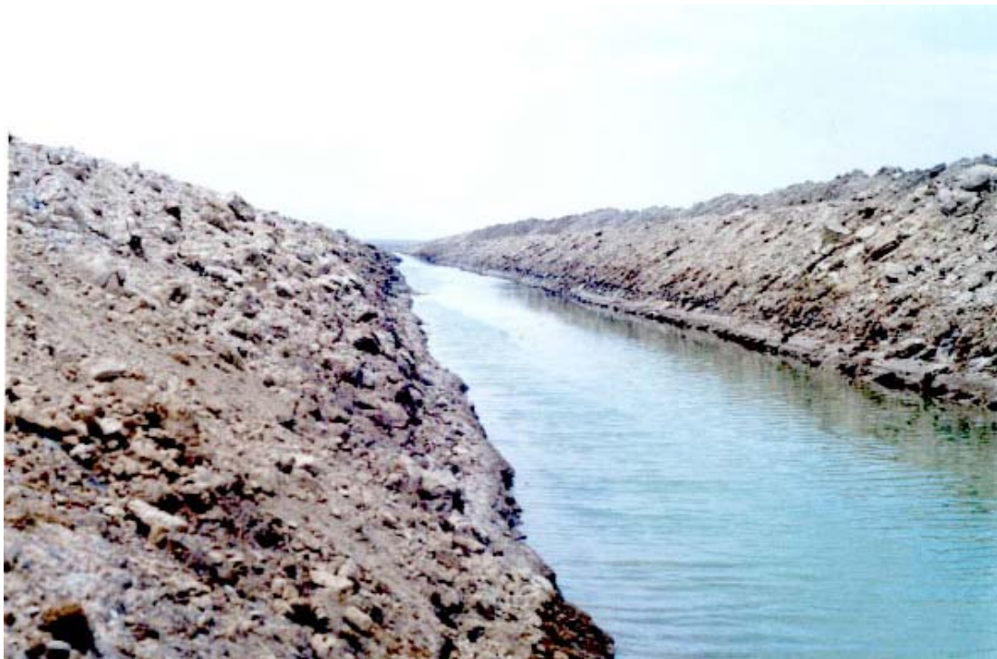
تصویر شماره (۸) - تراز بالای آب در کانال انتقال رودشت جنوبی قبل از اجرای پوشش
