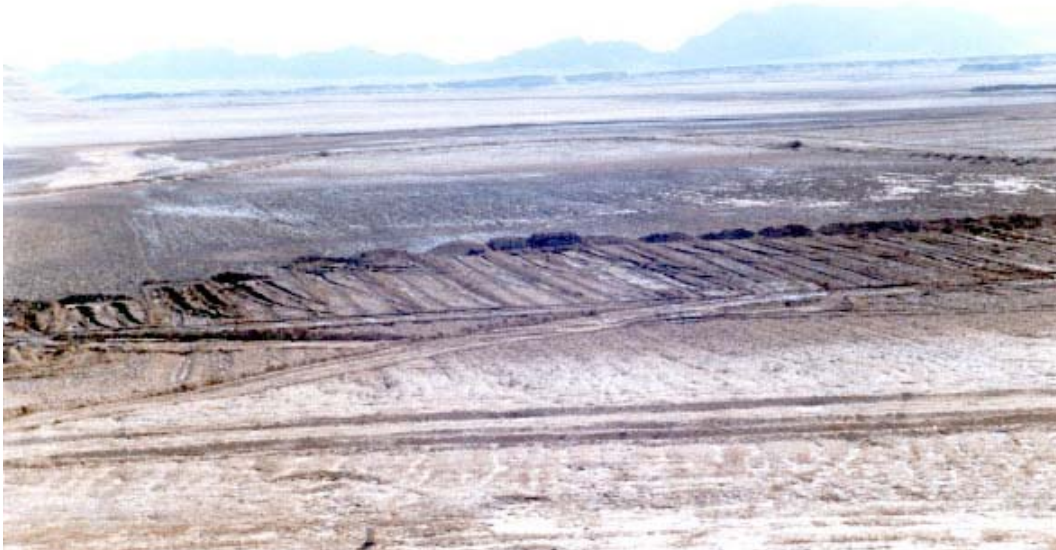
تصویر شماره (۱۱)- باتلاقی بودن مسیر کانال-آب زیرزمینی تقریباً ۱/۵ متر زیر زمین طبیعی است
