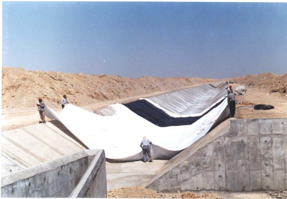
تصویر(۱-۱۴)- فرش کردن لایه اول بیدیم روی بتن محافظ زیر، در عملیات اجرای پوشش بوتیل برای محافظت پوشش کانال درمقابل املاح کلرید و سولفات و جلوگیری از فرار آب از کانال
