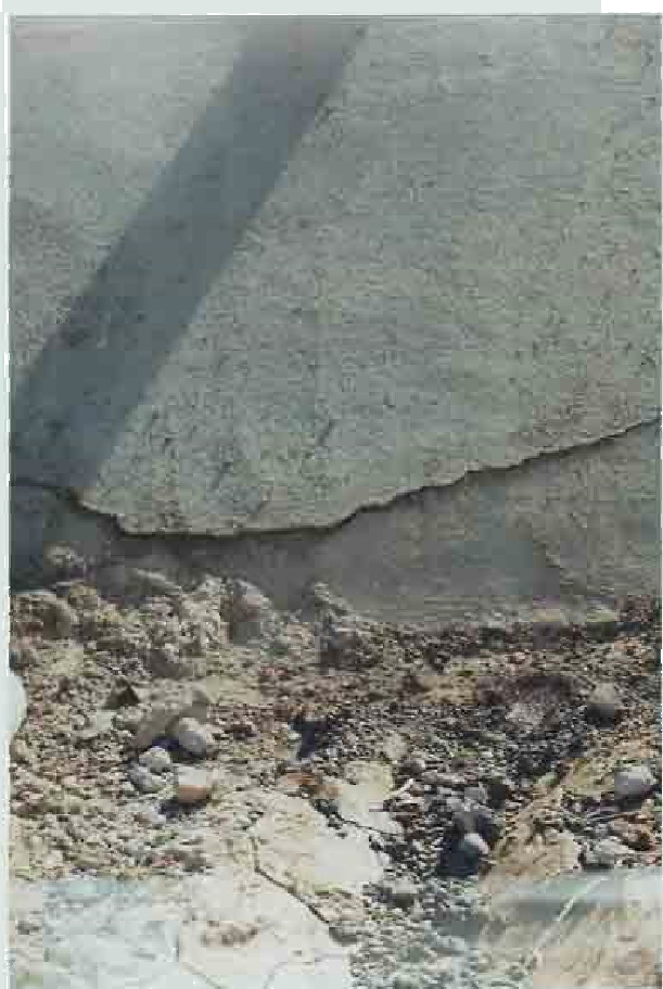
تصویر شماره (۴) - تخریب کانال در اثر فشار هیدروستاتیک
