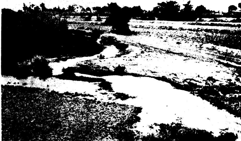
عکس شماره ۶- اگر کانالهای زراعی به درستی تعمیر نگردند و هیچگونه تاسیساتی در سیستم توزیع وجود نداشته باشند، راندمان مصرف آب پایین است.
