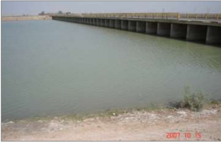
شکل ۵-۴- نمودی از مقدار آب پمپاژ شده از زهکشی مزارع در یکی از محل های تخلیه ی نهایی (پل پنجاه دهنه)
