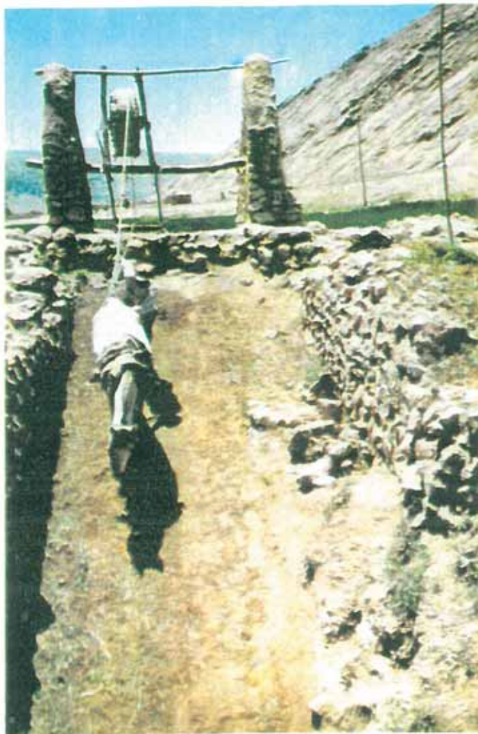
شکل ۱- طریقه آبکشی از چاه بوسیله نیروی حیوانی همانطوریکه مشاهده می شود بجای گاو، از اسب برای آبکشی از چاه استفاده می شود (عکس در سال ۱۳۴۲ در نزدیکی تخت جمشید برداشته شده است)
