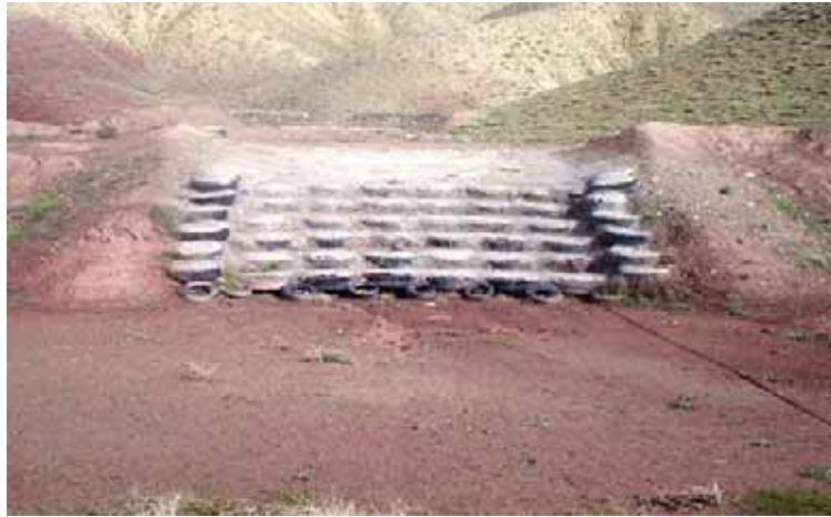
شکل شماره ۵ - نمونه ای از سرسره آبی پلکانی در محل اتصال آبراهه فرعی به کانال ذخیره آب
