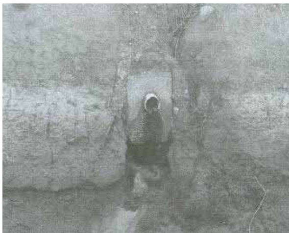
عکس ۱- خروجی زهکش زیرزمینی به کانال جمع‌کننده و مشاهده تجمع رسوبات آهن
