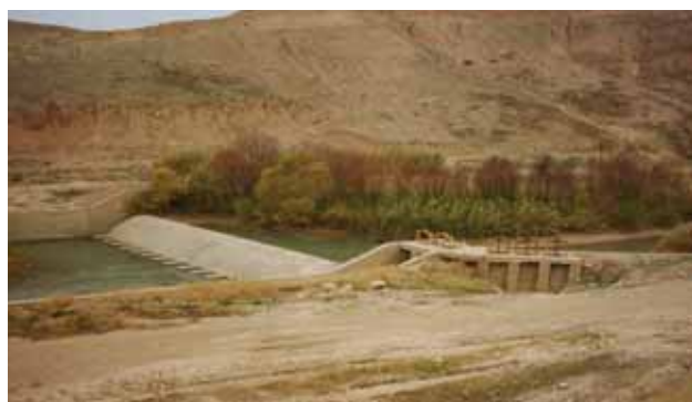
شکل (۳) - بند انحرافی احداث شده بر روی رودخانه قوره تو
