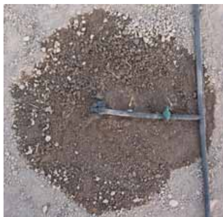
شکل (۲) - نحوه اتصال لوله آبد، سه راهی و قطره چکان
