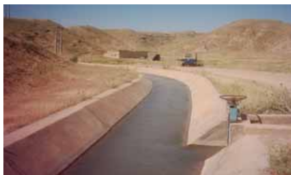
شکل (۴) - کانال انتقال آب از بند انحرافی
