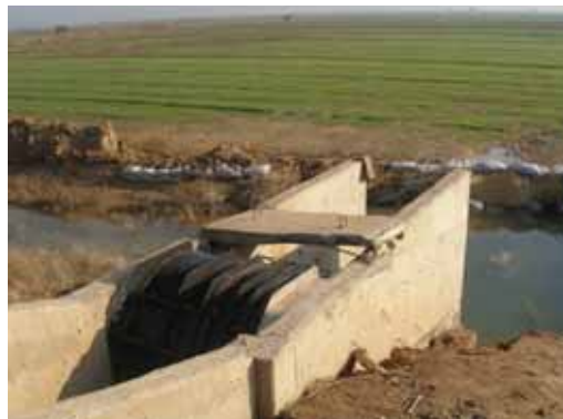
شکل (۱۲) - شکستن بتن برای درآوردن میلگرد
