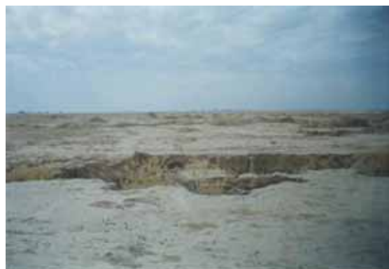
شکل (۸) - اجرای نامناسب طرح
