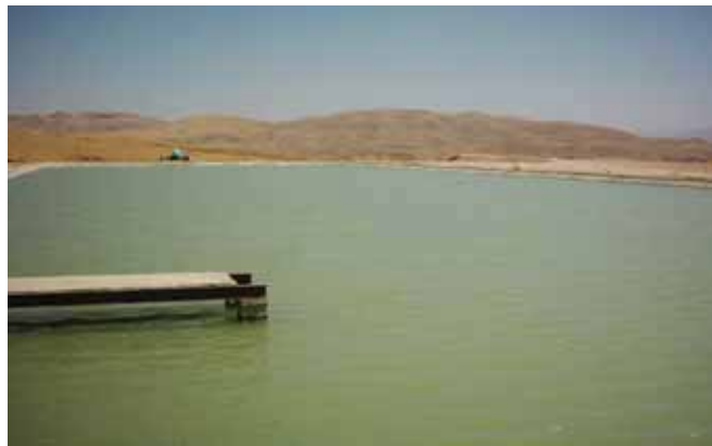
شکل (۶) - استخر ذخیره آب به حجم ۱۰۰۰۰ متر مکعب
