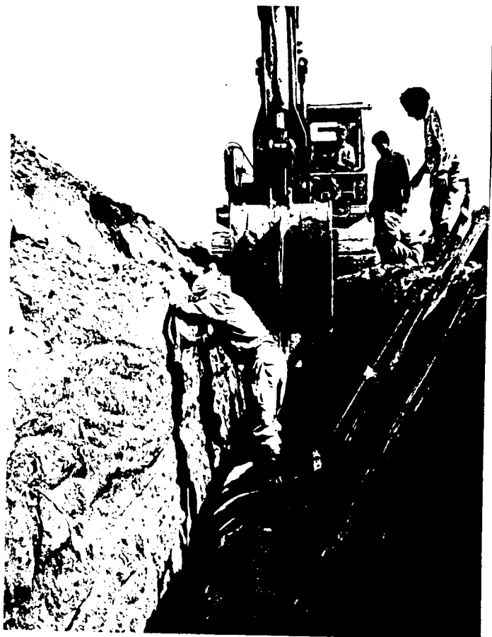
شکل ۶-۱۶ اجرای زهکش اصلی به صورت لوله زیرزمینی
