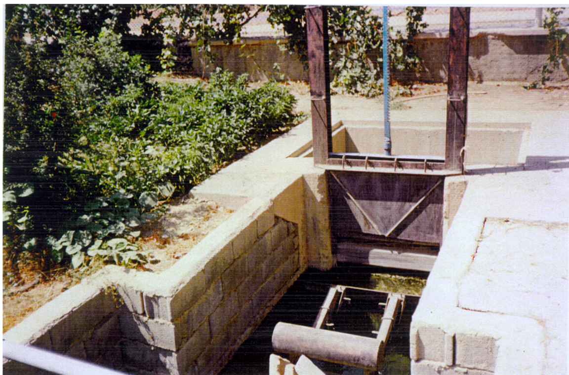
نمونه ای از آمیل همراه با اسلاید گیت - شبکه نکوآباد
