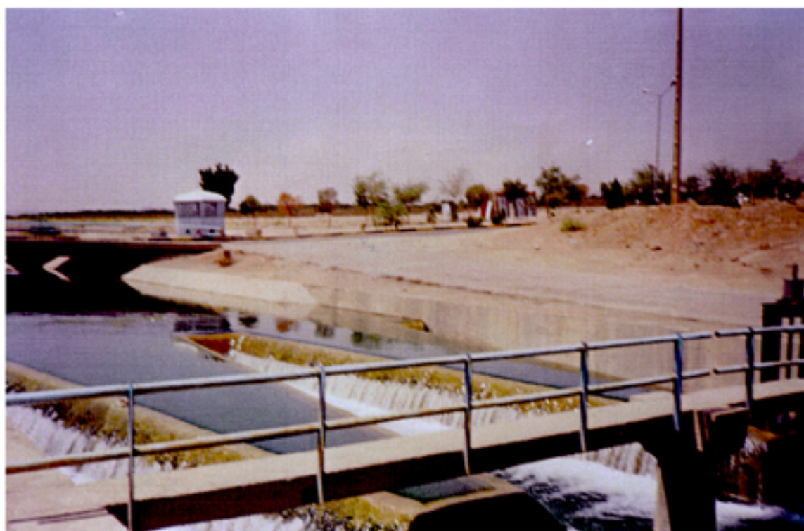
نمونه ای از سرریز نوک مرغابی دابل - شبکه برخوار
